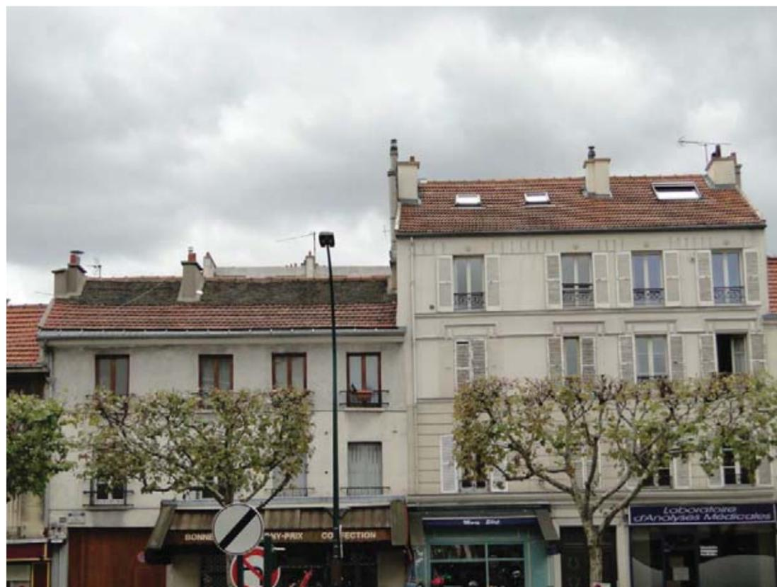
Remplacement partiel de la tuile plate d'origine par la tuile mécanique à emboîtement
