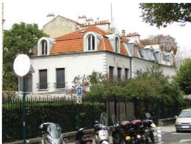
La tuile mécanique a remplacé l'ardoise
