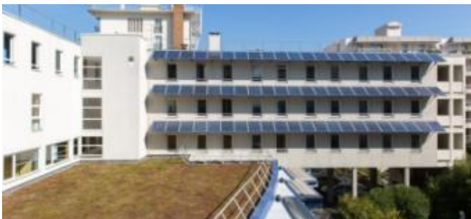
Espace Sorano : exemple de toiture végétalisée à Vincennes
