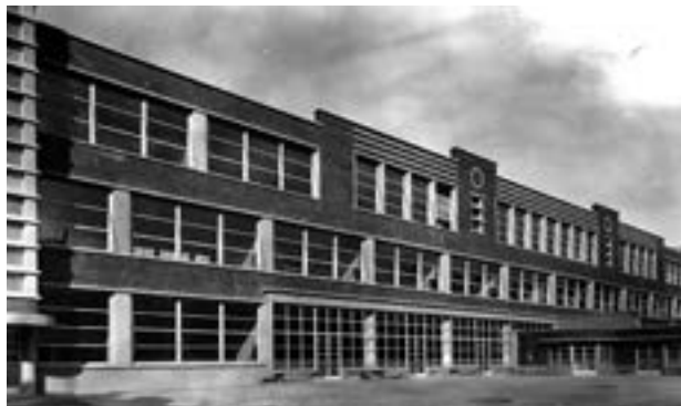
Groupe scolaire Sud. Façade sur cour. Vers 1939.
